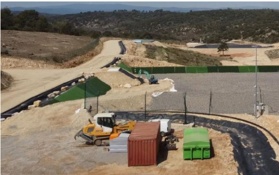
Aire stockage matériel
