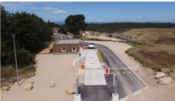
Pont-bascule et portique de détection de la radioactivité
