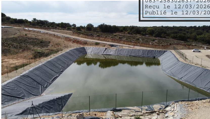
Bassin de stockage des ERI
