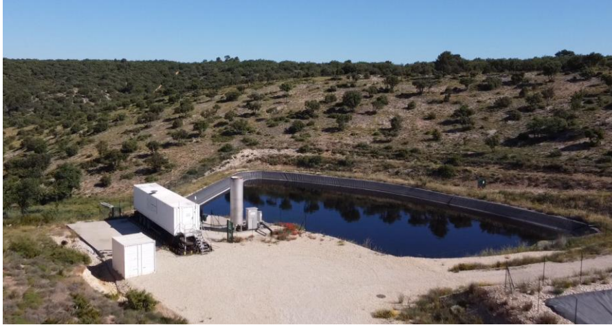
Bassin de stockage des lixiviats
