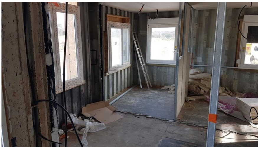
Assemblage et aménagement des conteneurs
