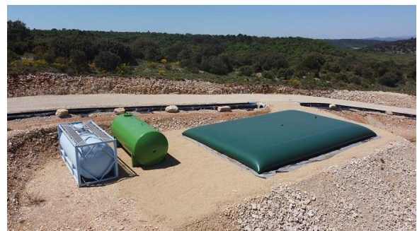
Cuves stockage et citerne incendie
