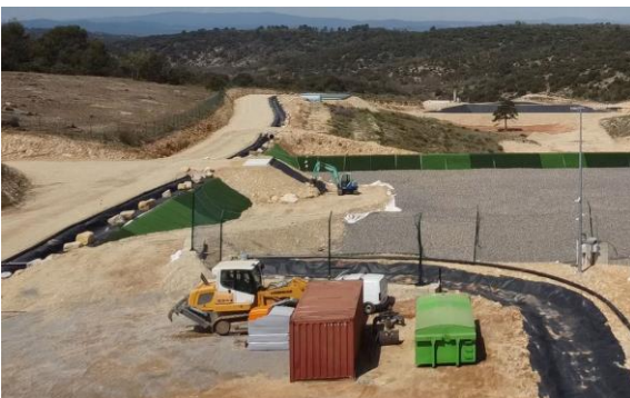
Aire stockage matériel
