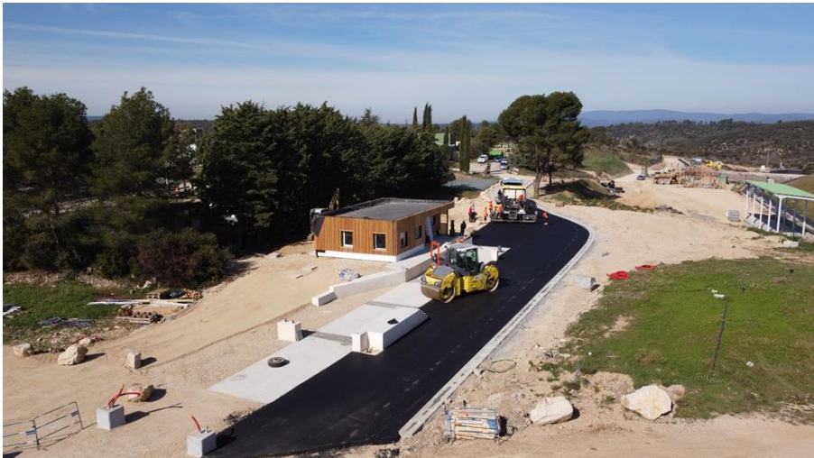
Pose de l'enrobé
