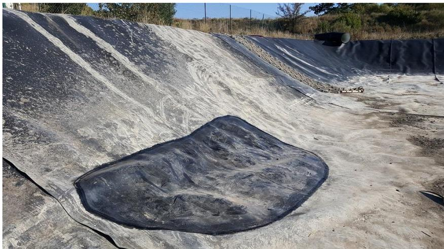
Réparation de la zone touchée par la benne preneuse (bassin ERI)
