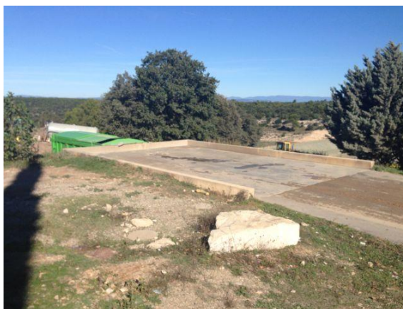
Aire de lavage
